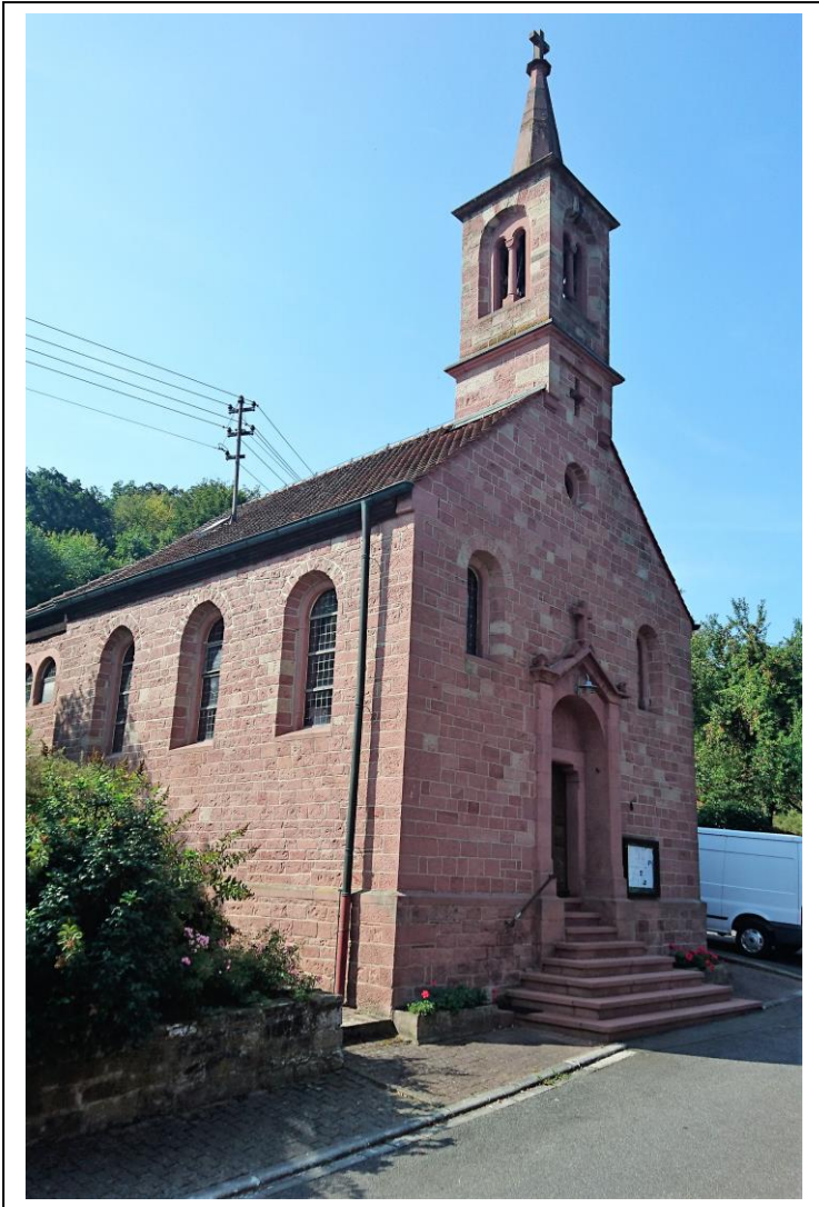
Kirche „Sieben Schmerzen Marien“ in Wessental Innenrenovierung abgeschlossen
